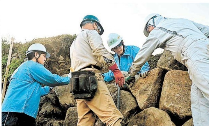
石積みの修復作業を行う職員ら＝恵那市中野方町、坂折棚田
