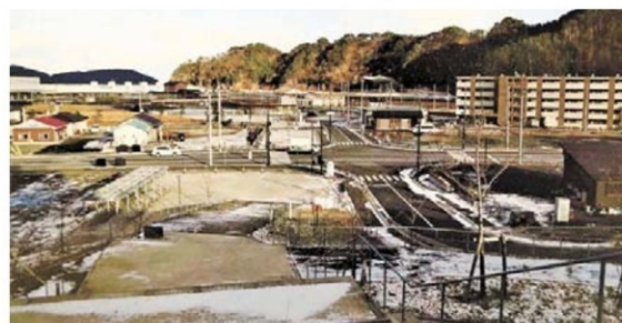
移転した新たな釜石東中学校から捉えた、旧校舎のあった街並み。住宅がまばらに立つのみだ＝1月1日、岩手県釜石市内(三浦寛行さん撮影)
