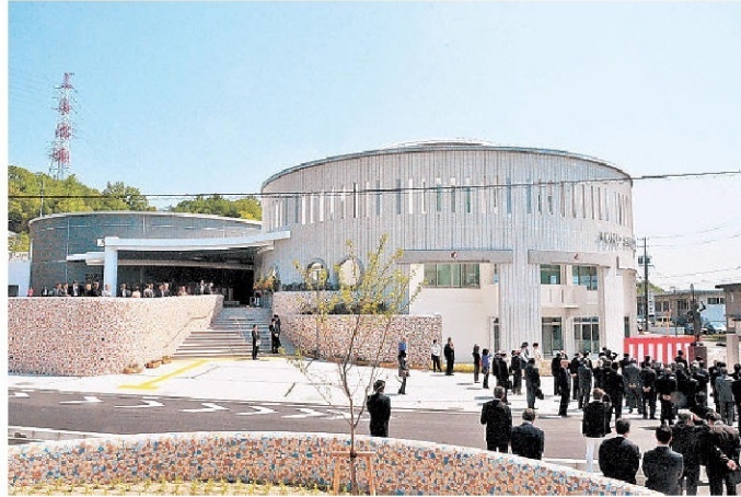
完成した「とうしん学びの丘 エール」=多治見市 虎溪山町
