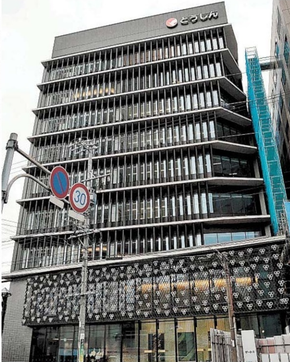
完成した東濃信用金庫の新本店。外壁の装飾には美濃焼のテラコッタが使われた。多治見市本町
