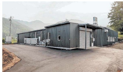
完成した北信州きのことファームのエノキ 生育工場＝長野県木島平村
