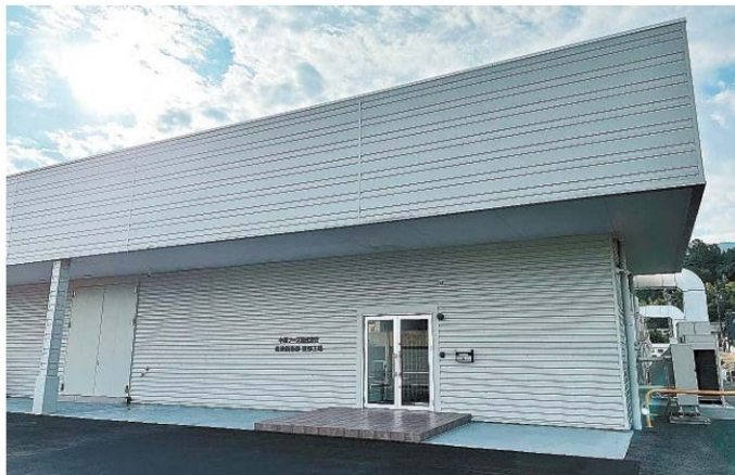
パンを生産する中部フーズの新工場＝恵那市長島町正家、北欧倶楽部 恵那工場
